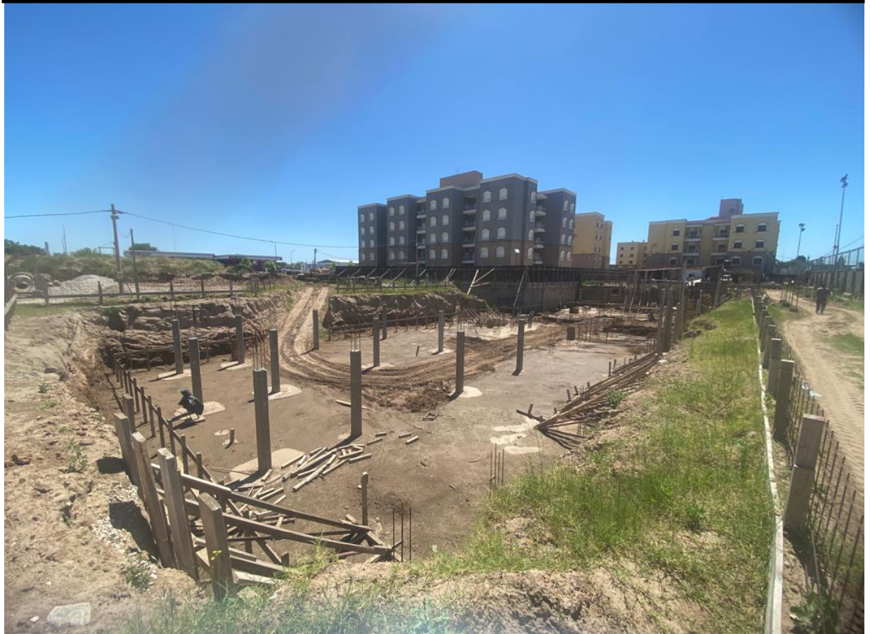
Excavación con bases del subsuelo
