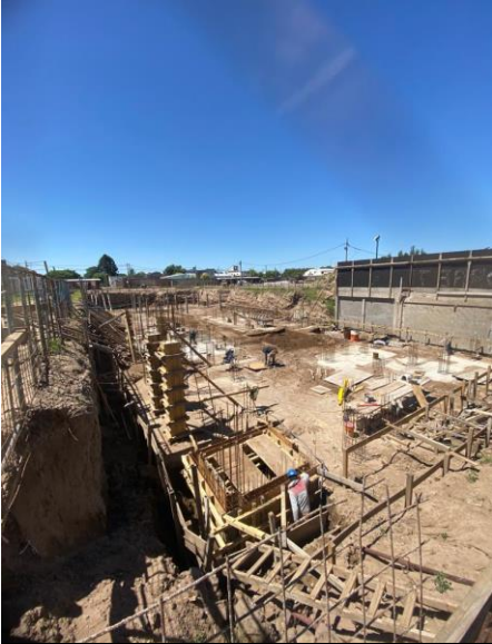
Tabique hueco Ascensor
