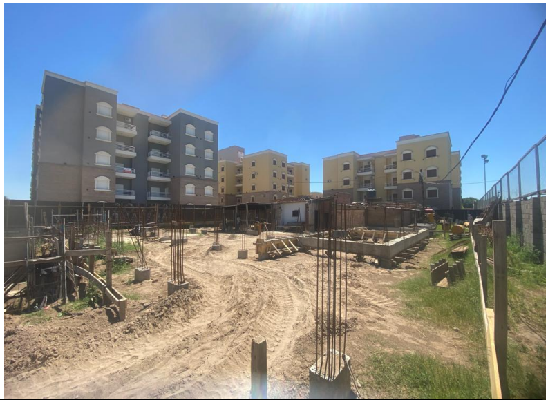
Vigas de Arriostre sobre planta baja
